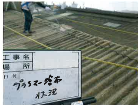
③プライマー塗布作業
