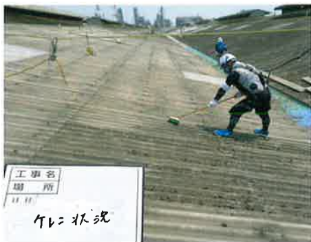
①下地ケレン作業
