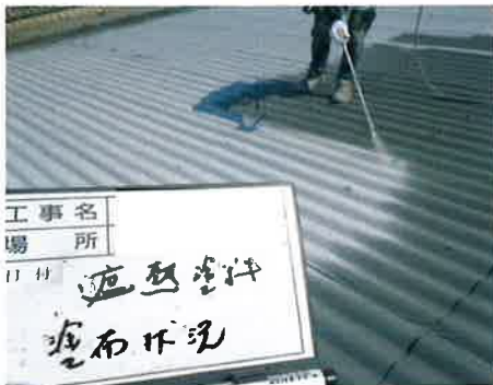
⑤遮熱トップコート 塗装作業
