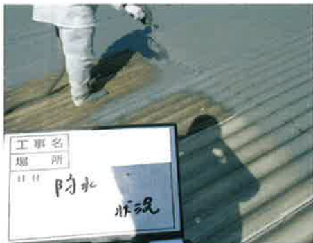
④ウレタン防水材 吹付作業
